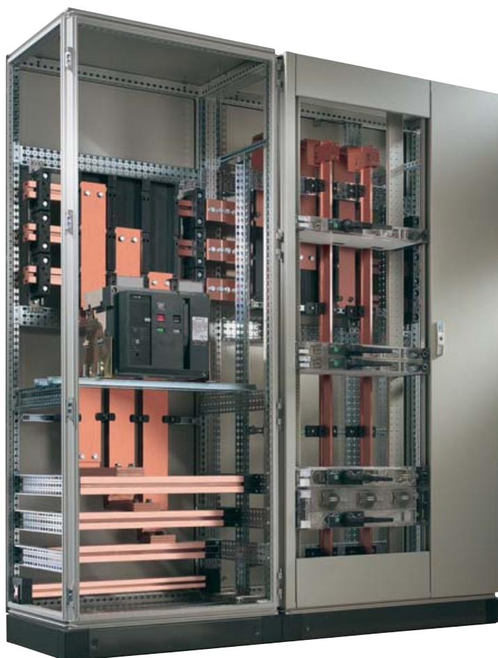
Устройство распределительного шкафа
